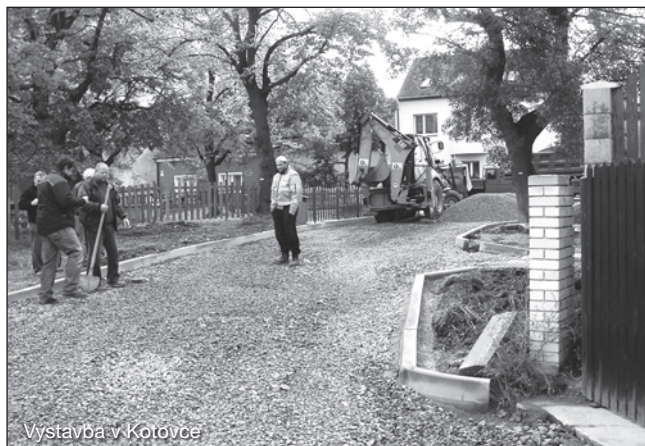
Výstavba v Kotovce
