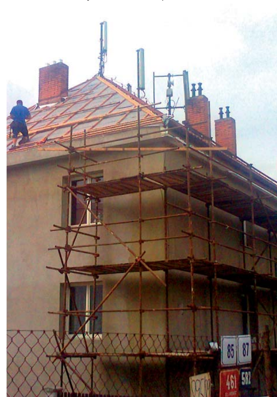
Rekonstrukce bytového domu č. p. 462
