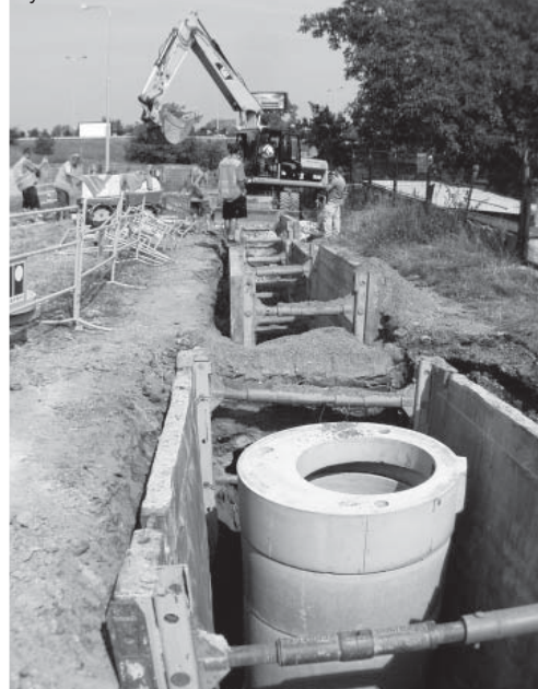
Výstavba kanalizace v ulici K Váze
