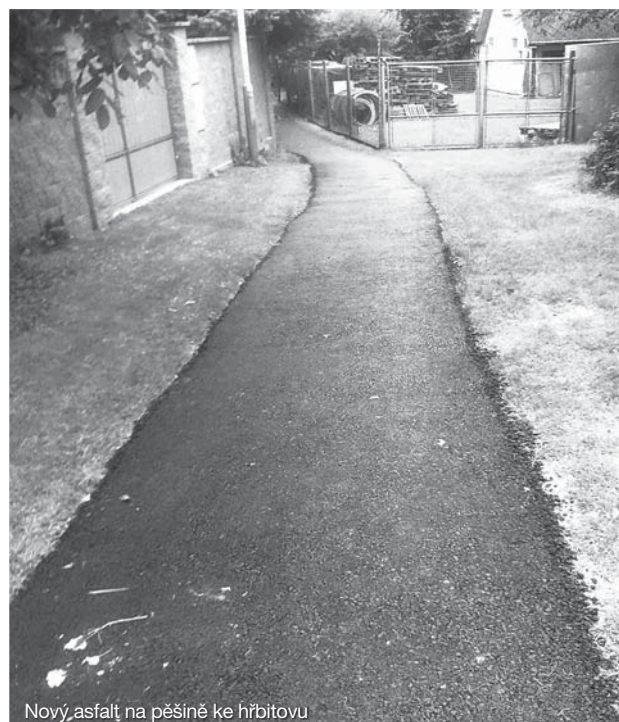
Nový asfalt na pěšině ke hřbitovu
