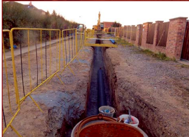
Výstavba dešťové kanalizace v ulici U Smolnic ▲ ▼
