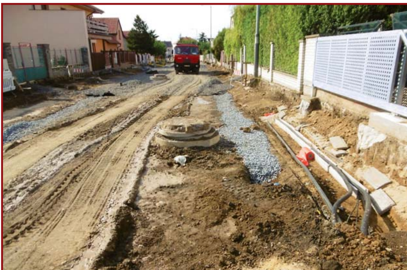
Rekonstrukce komunikace K Holyni
