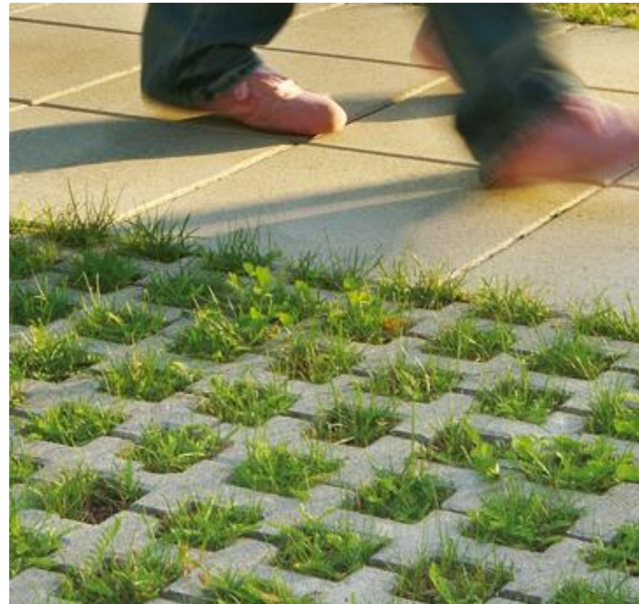
02 dlažba s otvory pro zatravnění - parkovací stání
